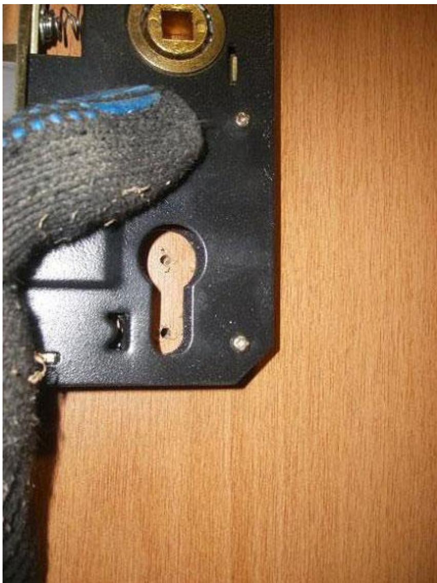
4) Просверлить отверстие под ключ.
