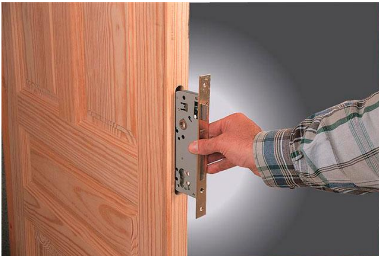
6) Закрепить замок с помощью шурупов.
