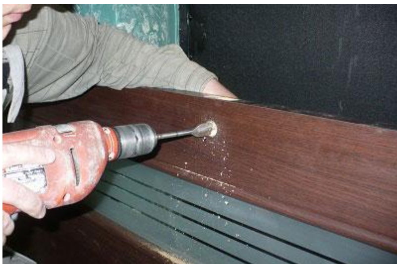
5) Вставить замок в отверстие.
